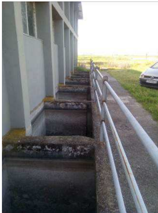
Εικόνα 3.6. (α) Αντλίες και αγωγοί εισόδου-εξόδου (β) Αγωγοί εξόδου (γ) Ταμιευτήρας αντλιοστασίου Ν2 (δ) Θάλαμοι εισόδου νερού από τον ταμιευτήρα
